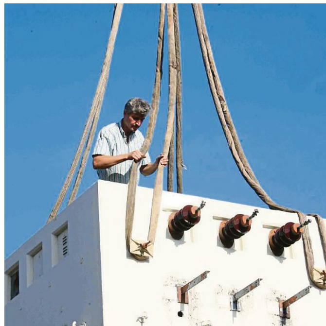
Legt selbst Hand an: Hausherr und Baumeister Gerald Siegl hat gute Vorarbeit für den Turmumzug geleistet.
