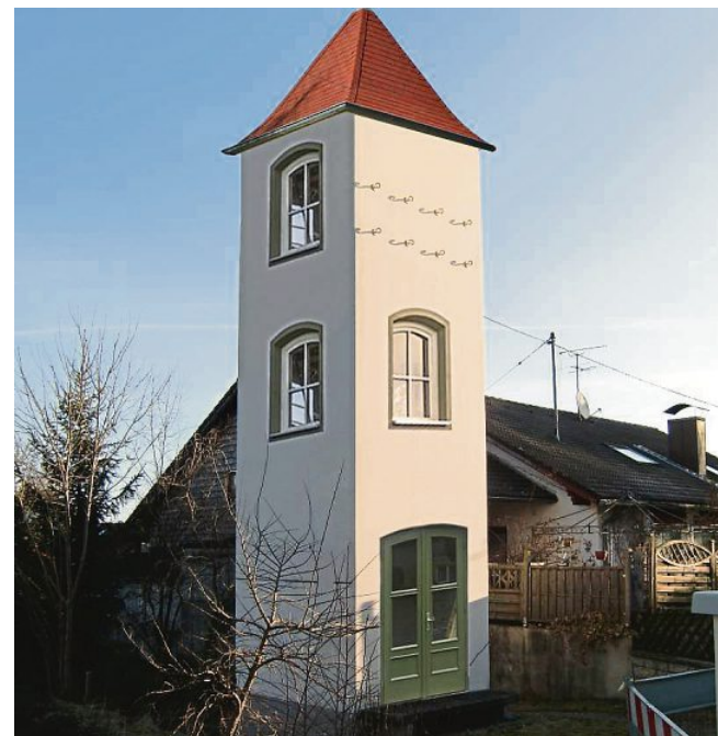
Der Trafoturm als experimenteller Wohn- oder Nutzraum – wie ihn sich Gerald Siegl vorstellen kann
