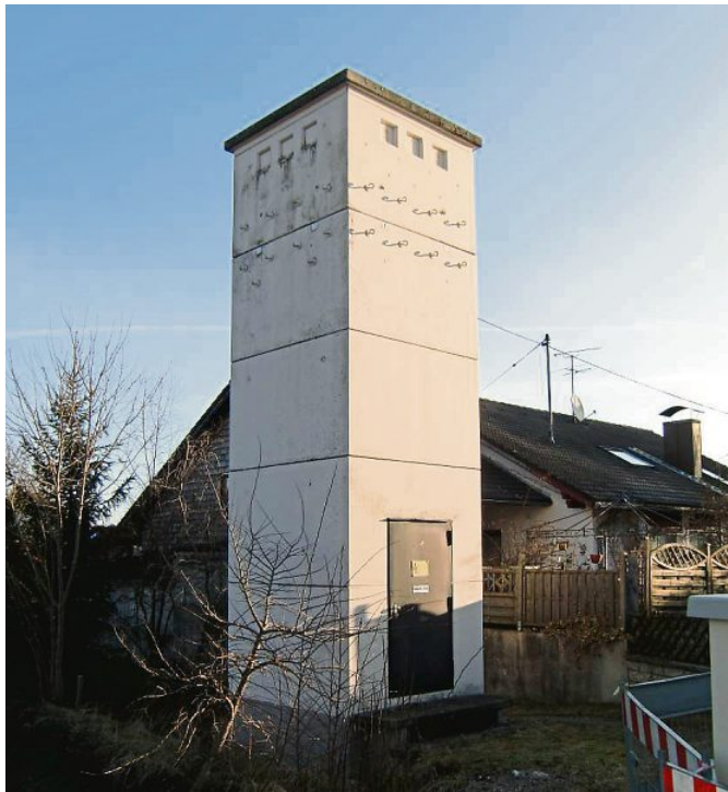
Der ausgediente Trafo-Turm in der Bahnhofstraße in Schwabbruck, wie er derzeit aussieht. FOTO/MONTAGE: SIEGL
